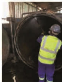
Application de RIG WASH PE dans une cuve
